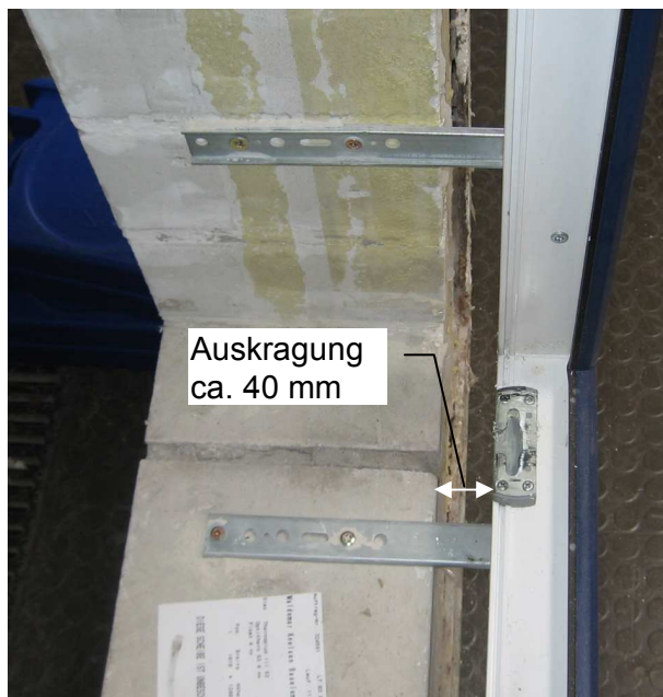
Bilder 5 bis 7 Lage der Befestigung im Profil- und Wandquerschnitt
