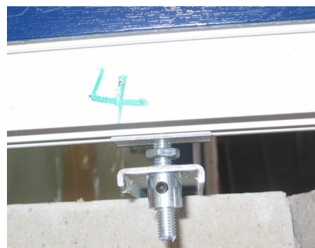
Bilder 5 bis 7 Lage der Befestigung im Profil- und Wandquerschnitt
