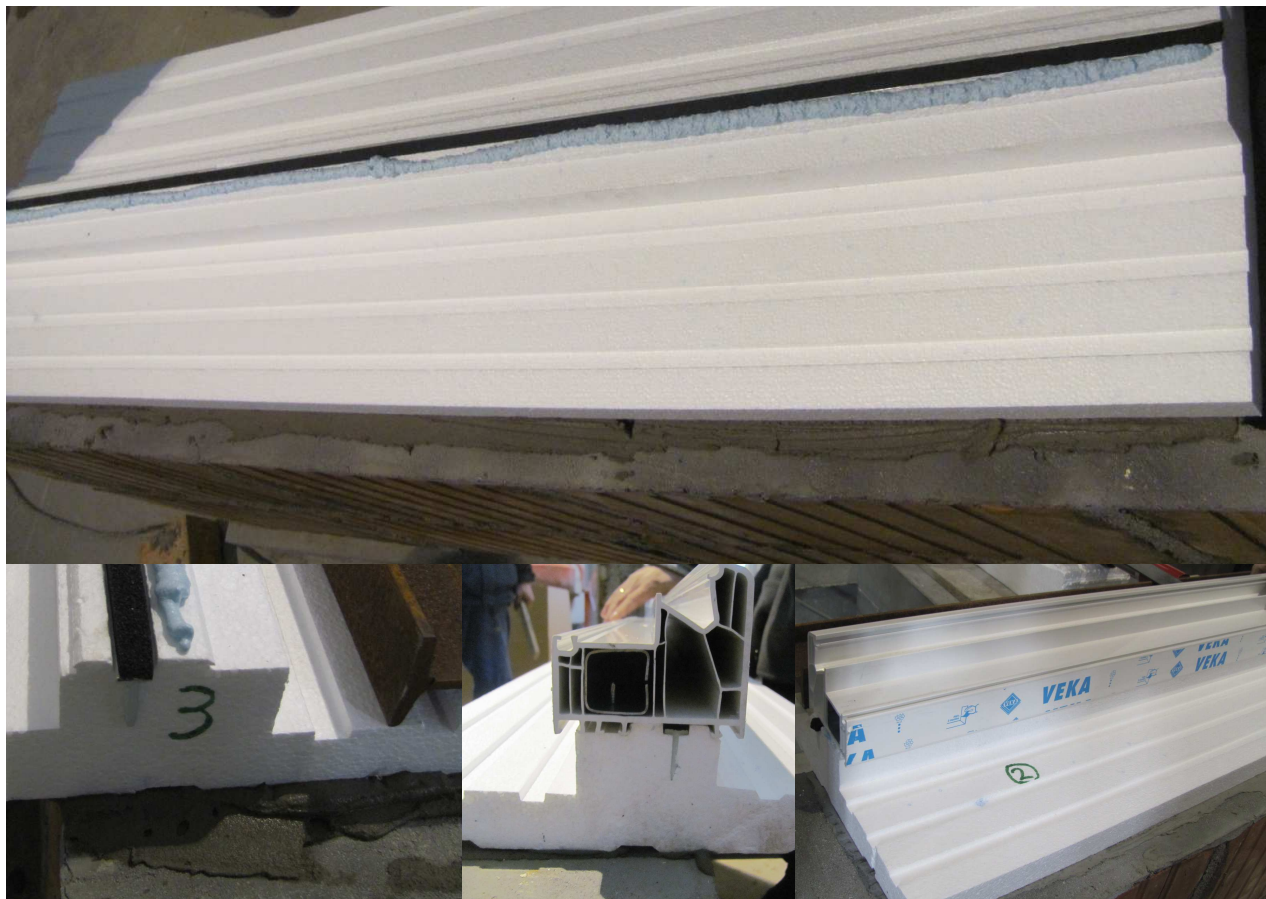
Fot. 5. Przykład sposobu przygotowania i montażu Próbkę do muru na zaprawę klejowo - szpachlową.
