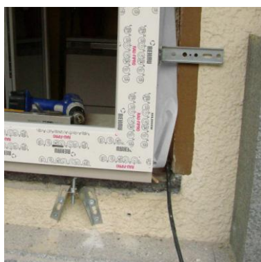
Renowacja z zastosowaniem konsol
