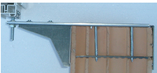
Przekrój – szyna wspomagająca + kątownik
